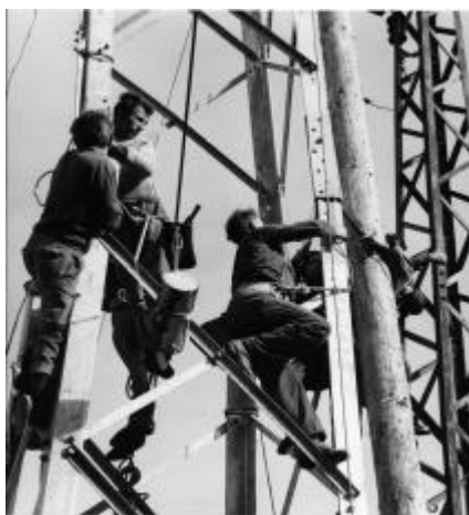
Montagearbeiten an Strommasten, Isar-Amperwerke AG, 1965
