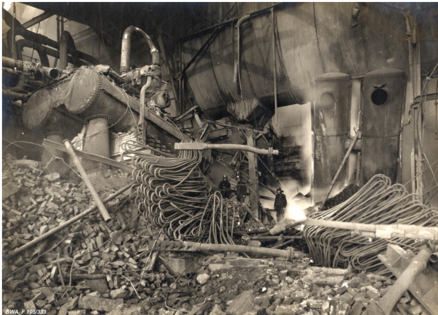
Der „Dämon Dampf“ hat zugeschlagen: Schwere Dampfkesselexplosion im Großkraftwerk Franken in Nürnberg, 1917
